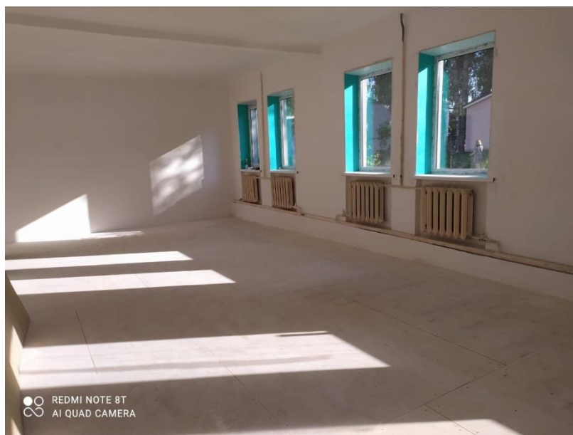
Стены подготовлены к покраске
