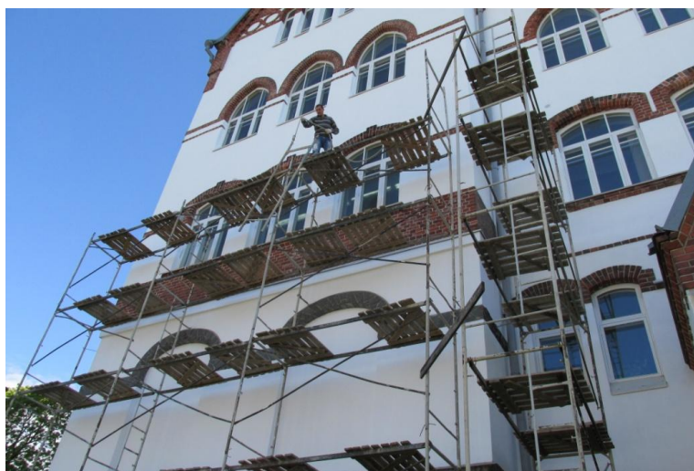
Фасад здания Сортавальской МРБ в процессе ремонта, 2015 г.
