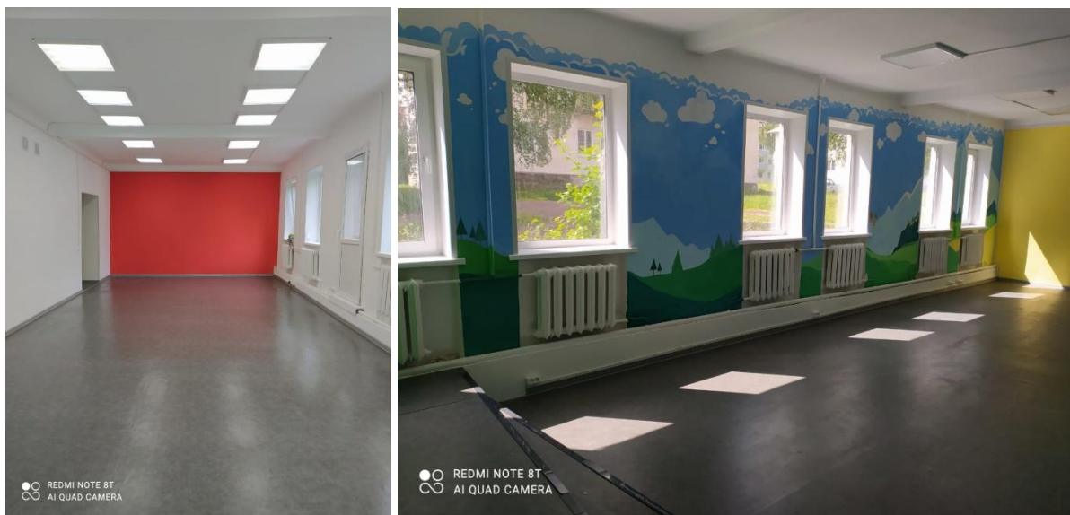
Ремонтные работы близятся к завершению
