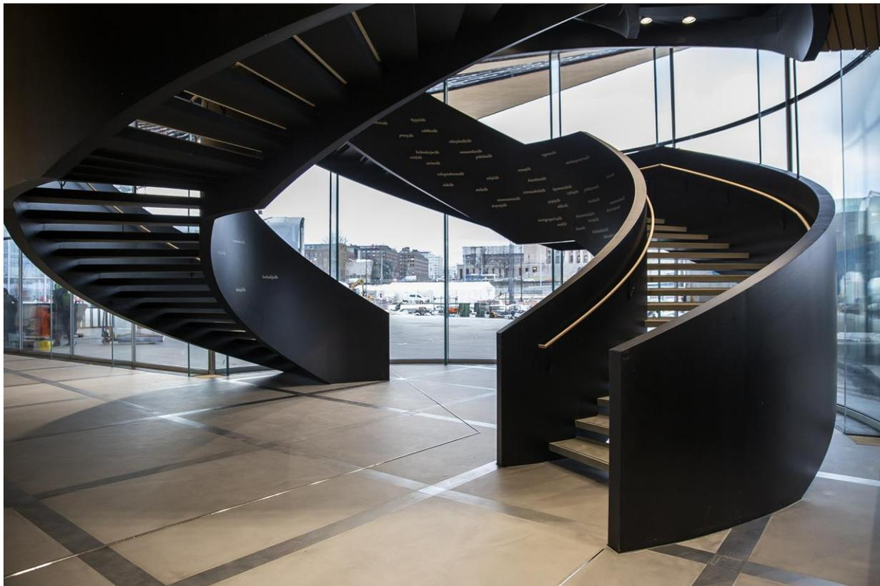
В вестибюле главного входа берет начало винтовая лестница, проходящая через все здание. Ее форма напоминает структуру спирали ДНК. Кажется, что черная стальная лестница весом 80 тонн парит в воздухе, потому что у нее нет опорных колонн, она опирается на конструкции промежуточных этажей.
