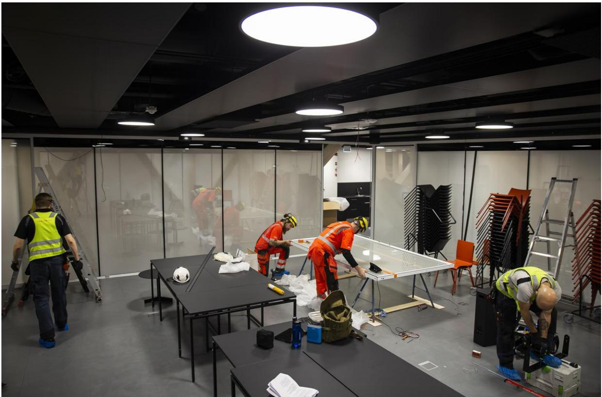
Умные стеклянные стены становятся темнее и ярче с помощью электрического тока. На них можно проецировать изображения. Помещение в сто квадратных метров будет использоваться, например, в качестве цифровой галереи искусств и виртуального учебного помещения.
