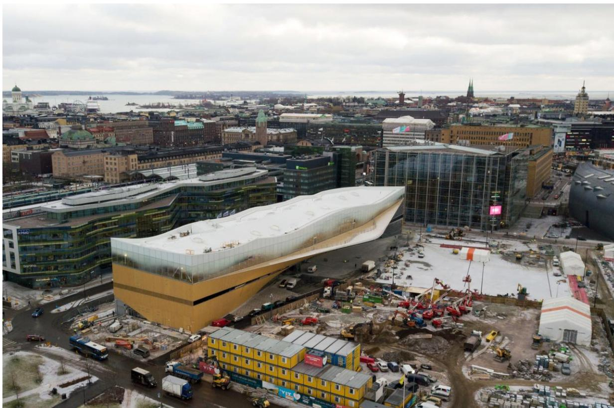
Дугообразная библиотека Ооди, напоминающая мост, построена на опоре из двух стальных арок длиной в 100 м. В качестве материала для фасада была выбрана отечественная ель, количество использованной при строительстве ели – 116 километров. Ель плохо переносит колебания погодных условий. Поэтому обработке деревянной поверхности было уделено особое внимание.
