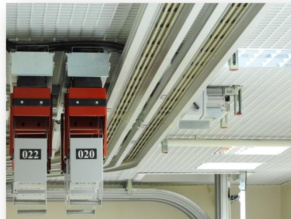
Монорельсовая транспортная система доставки документов
